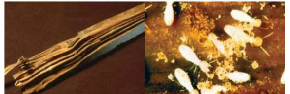
Madera afectada por termitas
